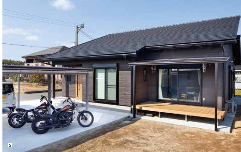
①キッチンからプライベートゾーンへの動線はコンパクトに。ピアノを置くホールは、床下補強をしっかりと施してある。②室内への採光や空間の広がりを与える引き屋根を採用。防汚機能を持つ外壁でメンテナンスもしやすい。
