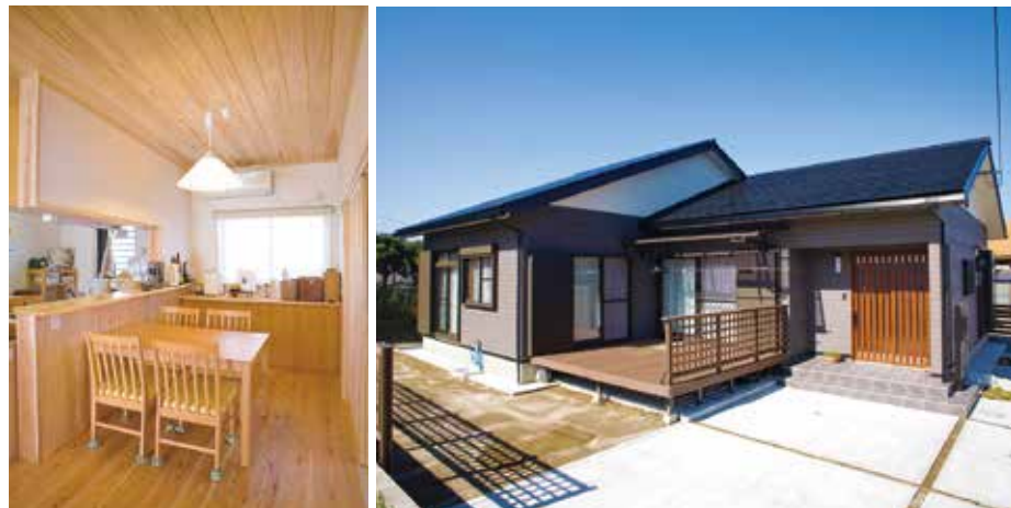
キッチンは壁付から対面式に変更し、使いやすさを実感。窓下の収納はオーダーメイド。 外壁には、汚れを分解し雨で流す光セラ外装材を使用。色あせを防ぐ機能もあり、長期間にわたって鮮やかさが保たれる。
